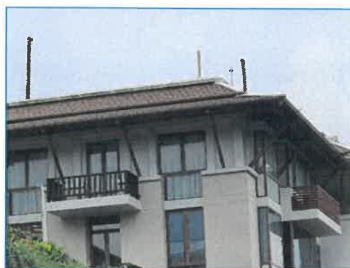
ภาพถ่ายที่ 2.2-14 เสาล่อฟ้า สายล่อฟ้า
