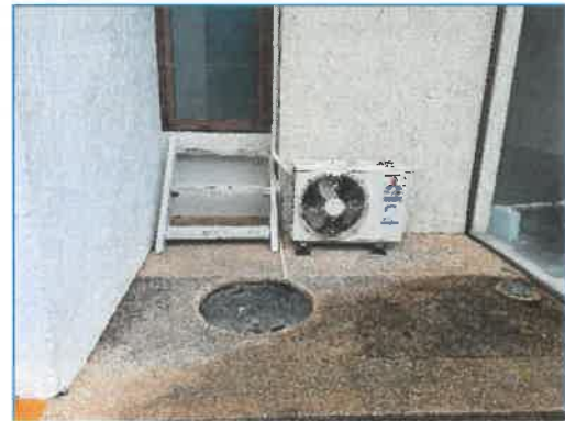
บ่อกักน้ำทิ้งก่อนเข้าระบบบำบัดน้ำเสียรวม
